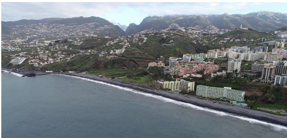
Figura 1 - Fotografia aérea geral da área de intervenção - voo realizado em 2021
